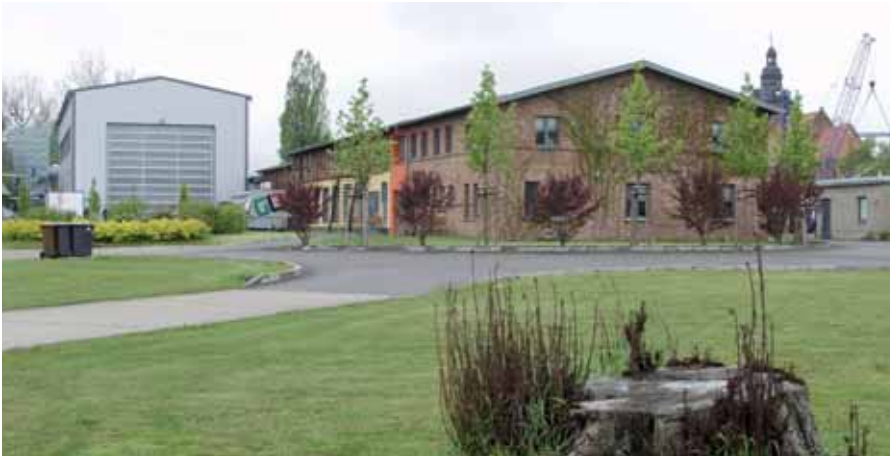
Das alte Werkstättengebäude wurde komplett modernisiert und rekonstruiert, das Werftgelände wie eine Parklandschaft gestaltet, in das sich die neue Schiffbauhalle funktional einordnet Fotos: A. Lewerken, Knoll (3)
